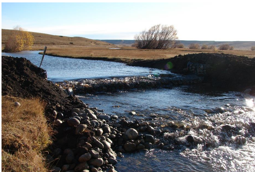
Figura 14. Azud nivelador sobre el cauce principal del río Coyle - Ea. Ruben Aike - Sur de la Provincia de Santa Cruz.
