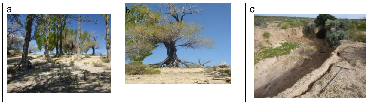
Figura 2. a y b) Erosión hídrica actual severa en la Región árida Serrana. c) Agrietamiento en talud del margen de cauce por escorrentía superficial y disolución de yesos en suelos de la cuenca del Río Colorado al Norte de la provincia (c).
