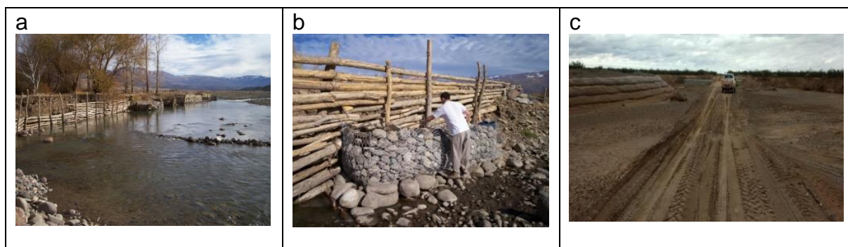
Figura 12. b y b) Tablestacas de madera de álamo y gaviones rellenos con rodados del lugar para protección de márgenes del río Curileuvú en el Norte de la provincia. c) Protección de márgenes con geoductos en cauces aluvionales efímeros en la cuenca del río Colorado.
