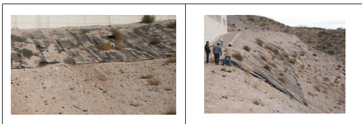
Figura 13. Geotextil para protección de la erosión laminar y la estabilización del talud de relleno en edificio Honorable Legislatura de Neuquén.
