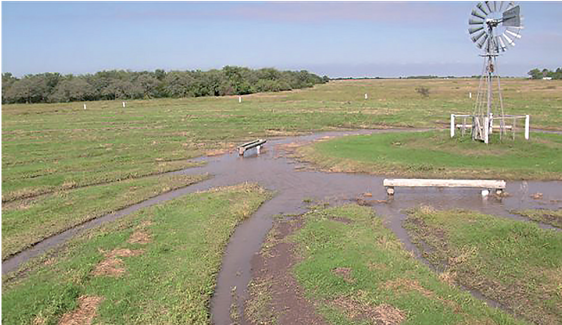
Ilustración 5. Sector sistematizado de recarga de acuífero con las perforaciones y molino que conforman un “Sistema Patas de Araña”. Fuente: Basan Nickisch, 2016.
